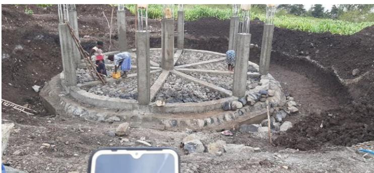
Für die dauerhafte Verfügbarkeit von Wasser auf dem Gelände Gamole wurde oberhalb eine Quelleinfassung vorgenommen. Ein Teilstrom der Quelle wird nun über einen Zwischenspeicher nach Gamole geleitet und kann dort für die unterschiedlichsten Zwecke genutzt werden.
