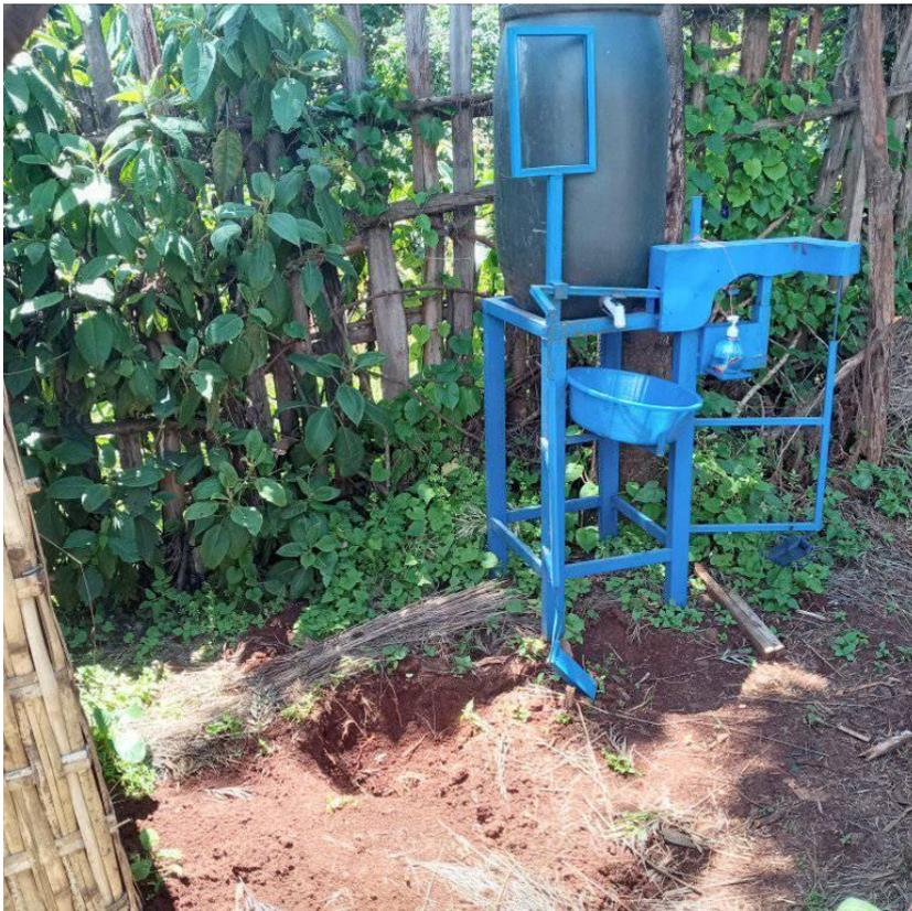
Abbildung 8 Diese mobile Station zum Hände waschen steht direkt neben der Komposttoilette. Wassertank, Seifenspender und Fußbedienung sind integriert. Abwasser versickert und dient umliegenden Bäumen zur Bewässerung
