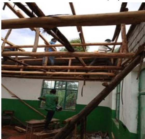
Foto: Renovierung Trainingszentrum- neue Dächer mit Solarmodulen zur Notstromversorgung
